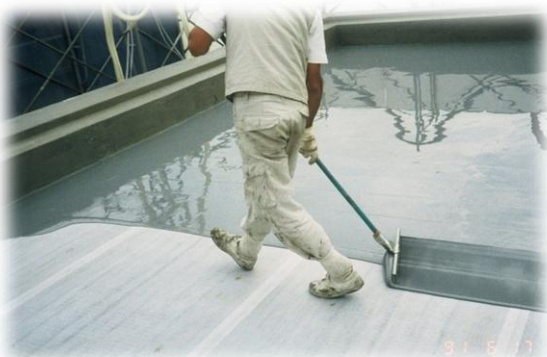
《 ウレタンによる塗膜防水 》
