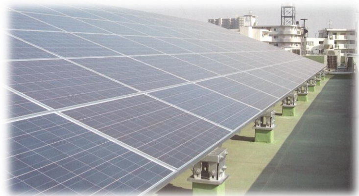
《 モジュールの取付け 》
