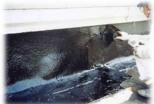
《 ゴムアスファルトによる塗膜防水 》
