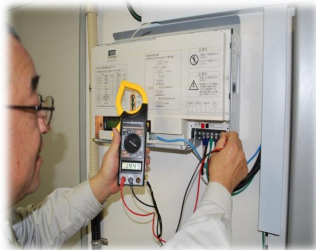
《 接続後の測定きによる確認 》
