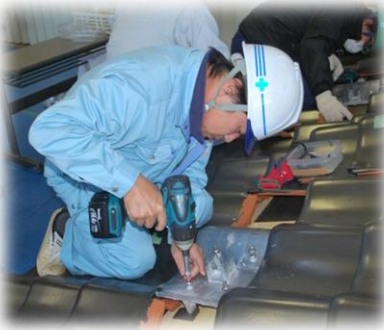
《 架台支持金具の取付け 》
