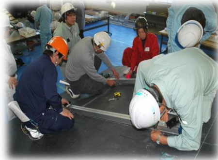
《 架台の取付け 》
