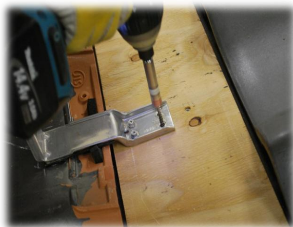
《 粘土瓦葺 支持金具方式 》
