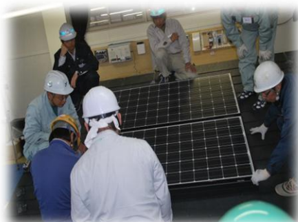
《 モジュールの取付け 》
