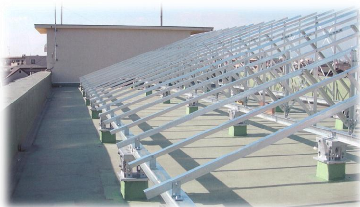
《 ベースレール及び傾斜ラックの取付け 》
