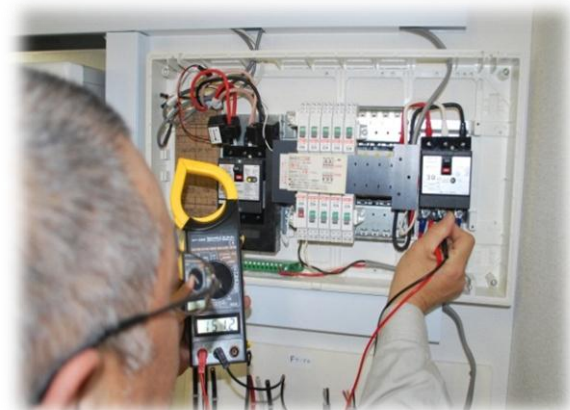
《 接続後の測定きによる確認 》
