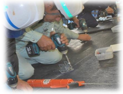
《 架台支持金具の取付け 》
